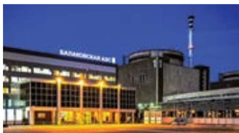
ООО «БалГЭМ» завершило работы на Балаковской АЭС → стр. 3
