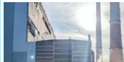
ООО «Камаэлектромонтаж» продолжает работы на объекте ПАО «Норильский никель» → стр. 8
