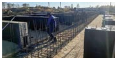
АО «ГЭМ» ведет строительство новой котельной «Вожаевка» в Амурской области → стр. 7
