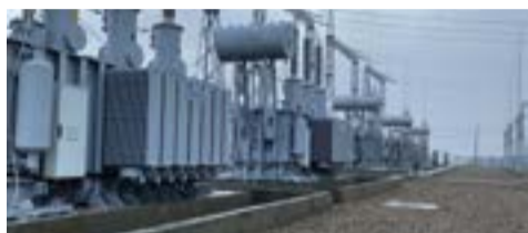
Специалисты БМУ ГЭМ построили ПС 220 кВ «Блуждающий» для электроснабжения Удоканского ГМК → стр. 4-5
