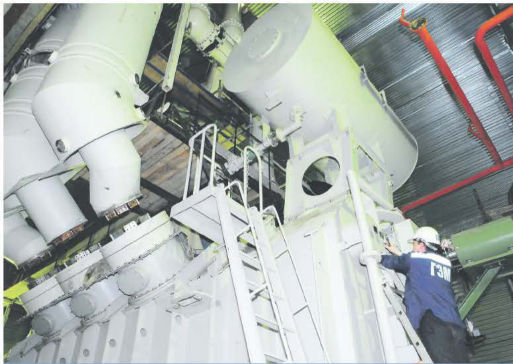
Работы на трансформаторе Богучанской ГЭС
