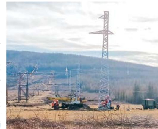
**Параметры строящейся ВЛ: длина — 20 км, пролеты по 300 м, опоры металлические одноцепные 110 кВ, три траверсы. Всего гэмовцам необходимо установить 89 опор».**
