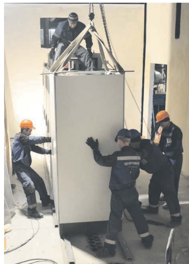
Монтаж шкафов на одной из отметок
