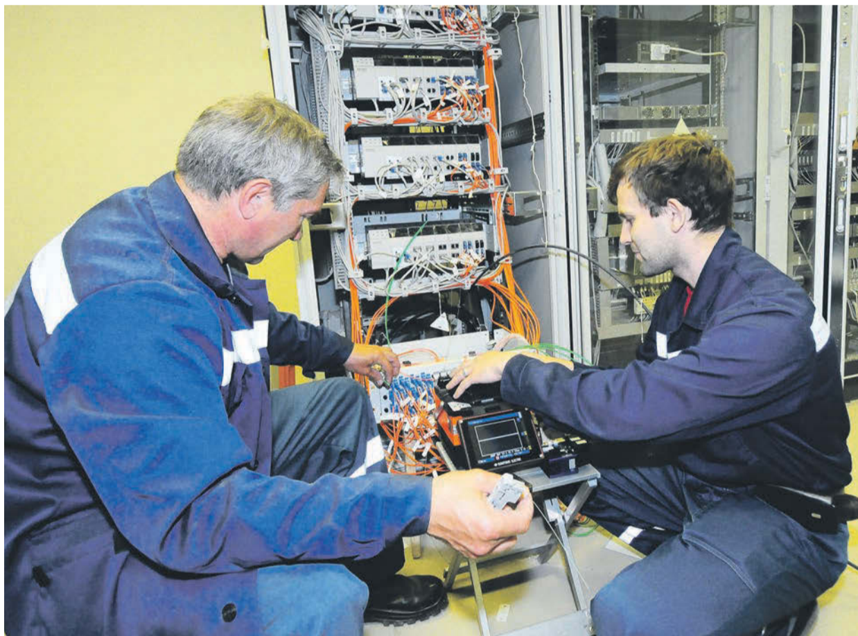
Настройка оборудования Богучанской ГЭС
