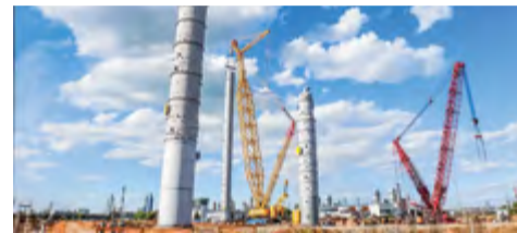
ООО «Гидроэлектромонтаж» заключило договор на выполнение работ на строящемся олефиновом комплексе «Этилен-600» → стр. 5
