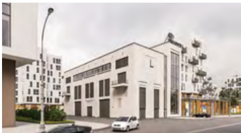
Специалисты БМУ ГЭМ построили подстанцию в центре Иркутска → стр. 2
