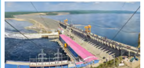
Богучанская ГЭС отмечает десятилетний юбилей пуска первого гидроагрегата → стр. 6
