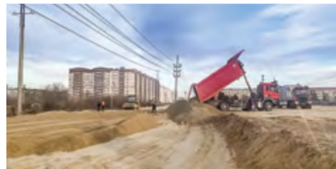
Завершены подготовительные работы для начала строительства газовой котельной в Благовещенске → стр. 3
