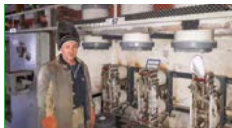
Кэмовцы ведут работы на объекте «Мосэнерго» → стр. 4
