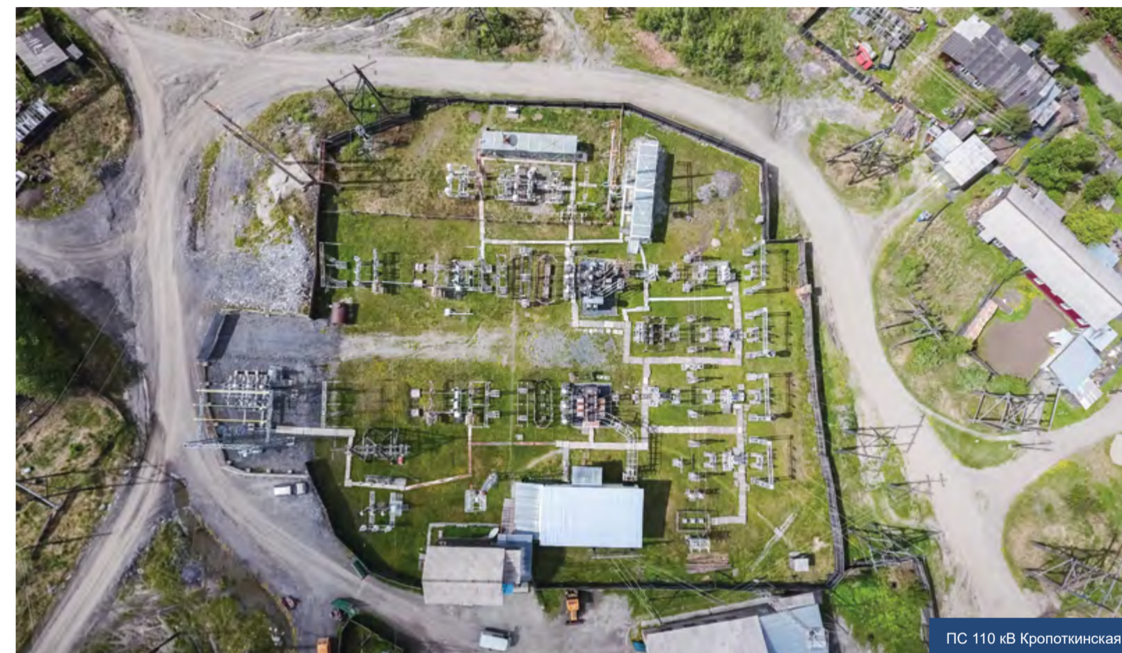
ПС 110 кВ Кропоткинская
