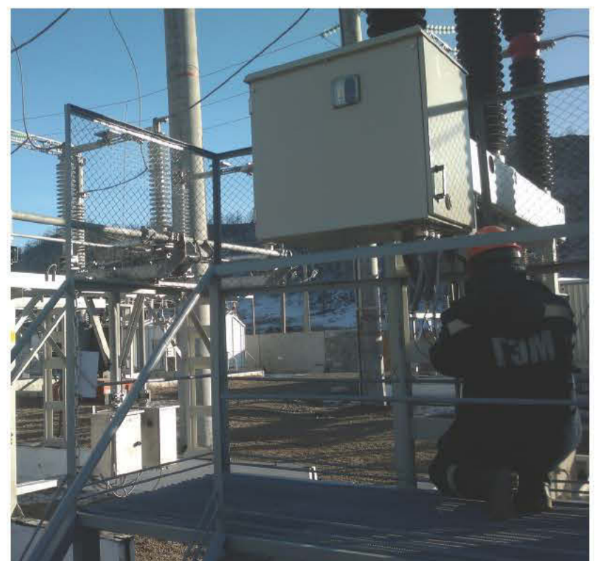
Реконструкция ПС 110/10 кВ Черноруд
