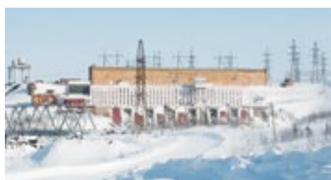
БалГЭМ строит Усть-Хантайскую ГЭС: ход работ
