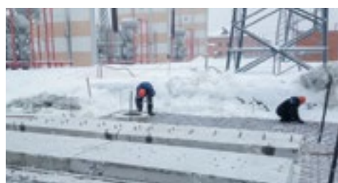
АО «ГЭМ» ведет реконструкцию ПС 220 кВ «Белозерская»
