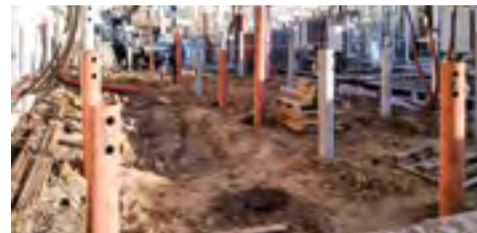
Благовещенский филиал АО «ГЭМ» реконструирует ПС 35/10 кВ «Амур» → стр. 6
