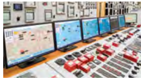
ООО «ГЭМ» завершили модернизацию и реконструкцию Заинской ГРЭС → стр. 6
