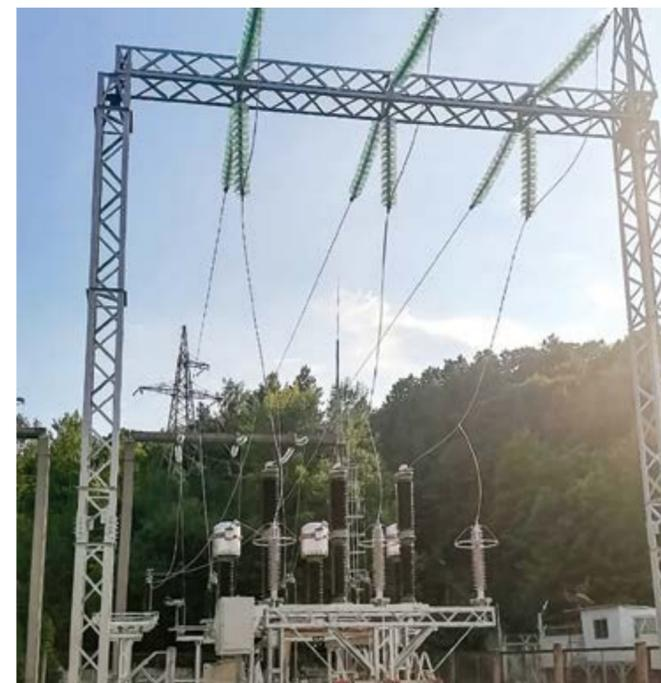
*В зону ответственности кэмовцев в рамках модернизации ОРУ-110/6 кВ ГПП Водозаборные сооружения по заказу ООО «ЧЕЛНЫВОДОКАНАЛ» входит демонтаж старого оборудования, монтаж фундаментов, первичного оборудования, шкафов и пусконаладочные работы на двух ячейках подстанции»*
