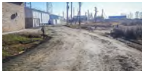
Закончено строительство подъездной дороги к ПС 110 кВ «Маслозавод» → стр. 4
