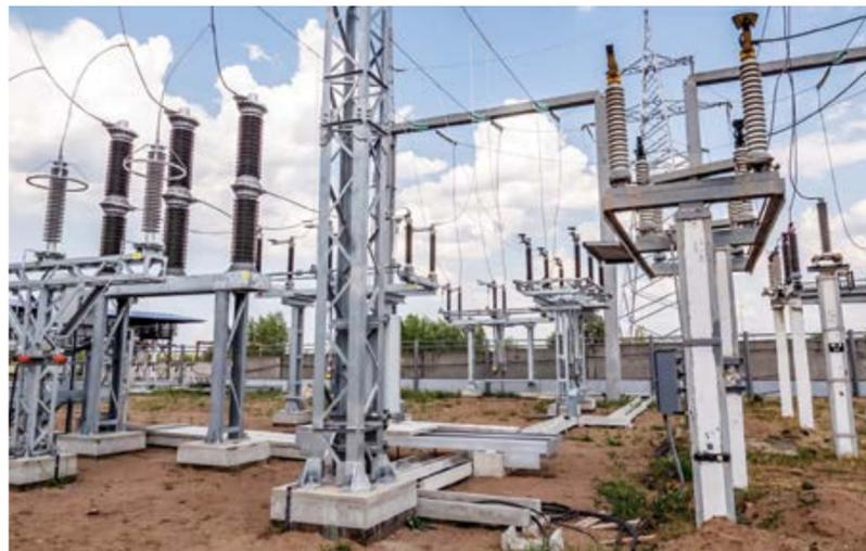
Специалисты ООО «ГЭМ» полностью завершили модернизацию одной ячейки ОРУ-110 кВ ГПП-РОС ООО «Челныводоканал», ведут монтажные работы на второй ячейке подстанции».
