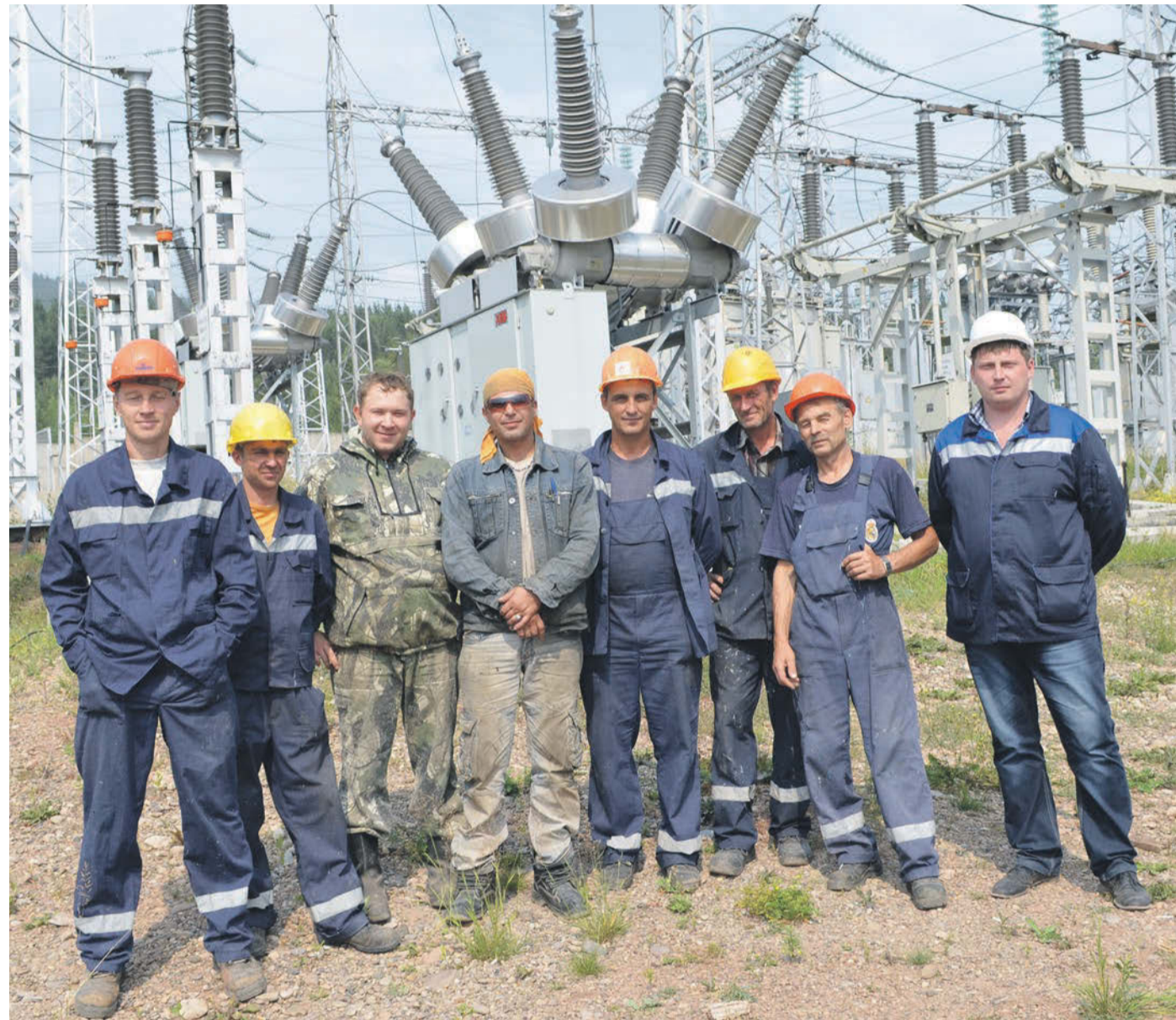
Бригада Братского участка БМУ ГЭМ, работающая на ПС 220/110/35/кВ «Лена»
