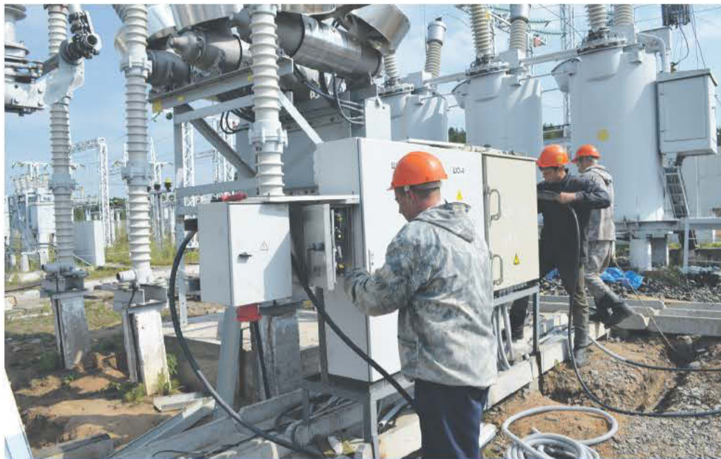
Подключение нового элегазового выключателя 110 кВ
