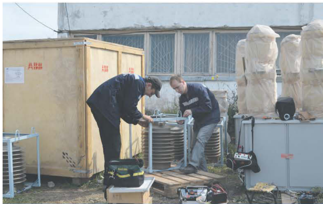
Испытание трансформаторов тока 35кВ
