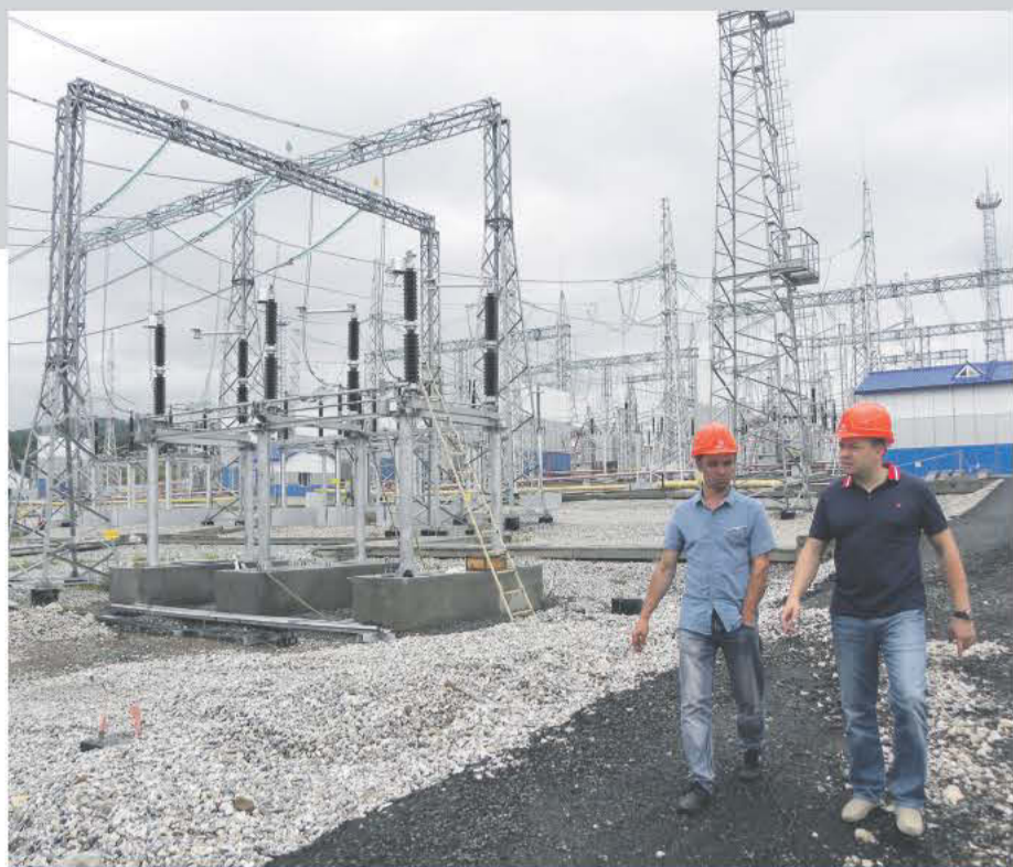
Прораб Алексей Аникин контролирует ход строительства
