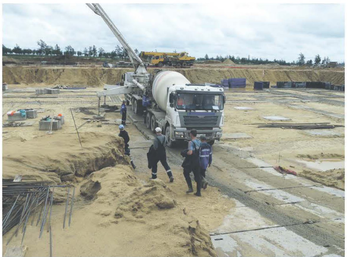
Стройплощадка базы МЧС космодрома «Восточный»
