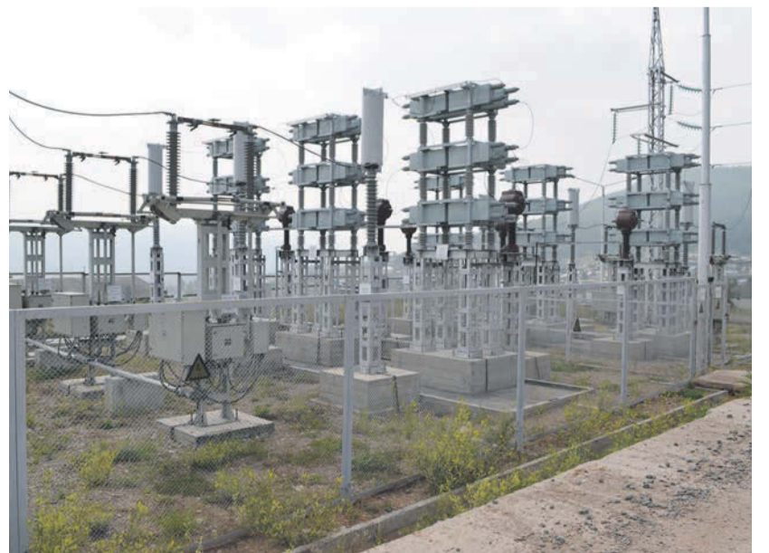
Новая БСК 110 кВ
