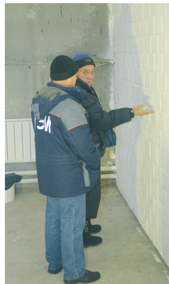
Проверка качества ремонтных работ
