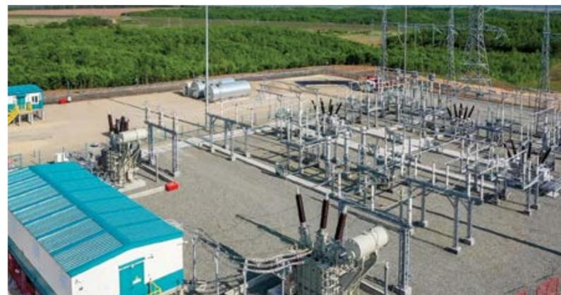
ПС 220 кВ «Строительная» установленной мощностью 2\*40 МВА подключена к транзиту принадлежащей «Россети ФСК ЕЭС» магистральной линии электропередачи ВЛ 220 кВ «Свободненская ТЭС — Новокиевка». Мощность в данную ЛЭП передают две крупнейшие ГЭС Дальнего Востока — Зейская и Бурейская. Запуск ПС 220 кВ «Строительная» позволит свести к минимуму использование на стройплощадке
