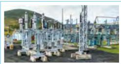
Специалисты БМУ ГЭМ ведут работы по установке конденсаторных батарей на ПС 110 кВ «Перевоз»  $\stackrel{\searrow}{}$  стр. 4
