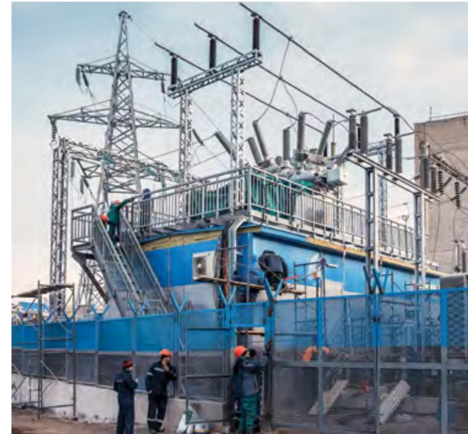
Современный комплекс РЗА ПС 110 кВ «Молодежная», основанный на микропроцессорных устройствах, поддерживающих стандарт МЭК-61850, впервые позволит реализовать на Молодежной технологию разра-
