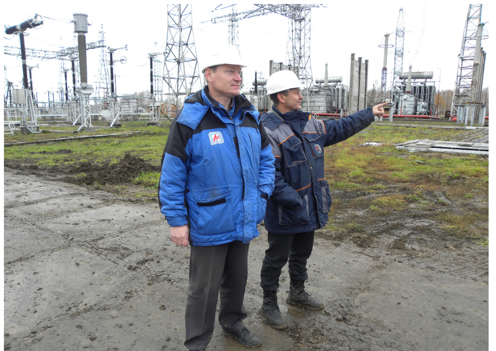
Евгений Токарев и Виктор Вагин обходят территорию подстанции
