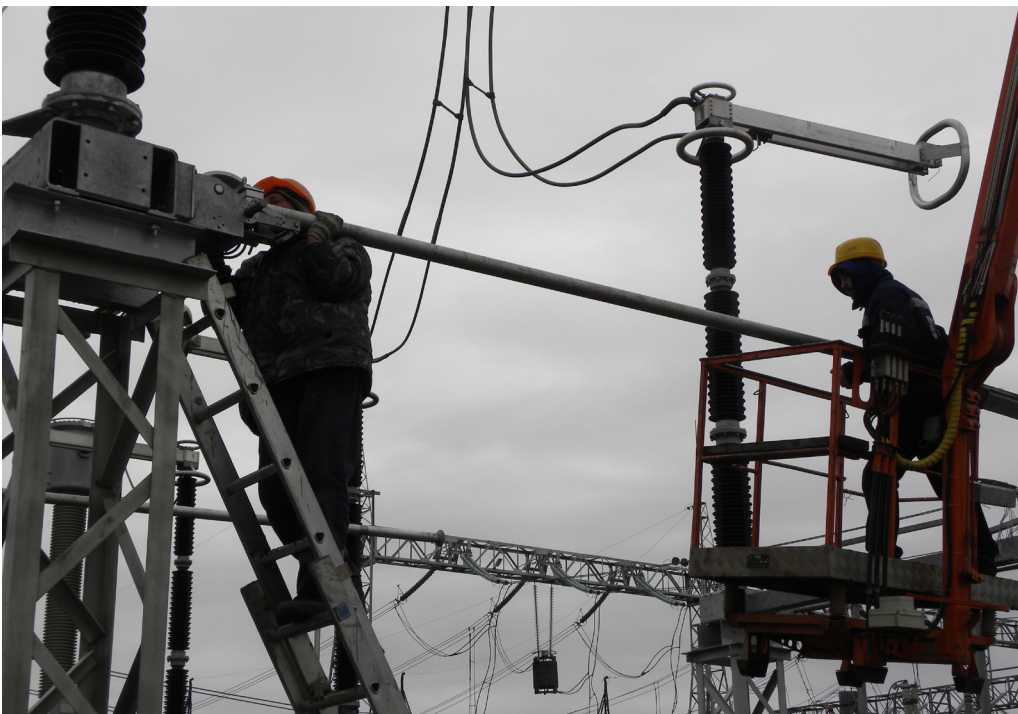
Монтаж электрооборудования на ПС «Тайшет»
