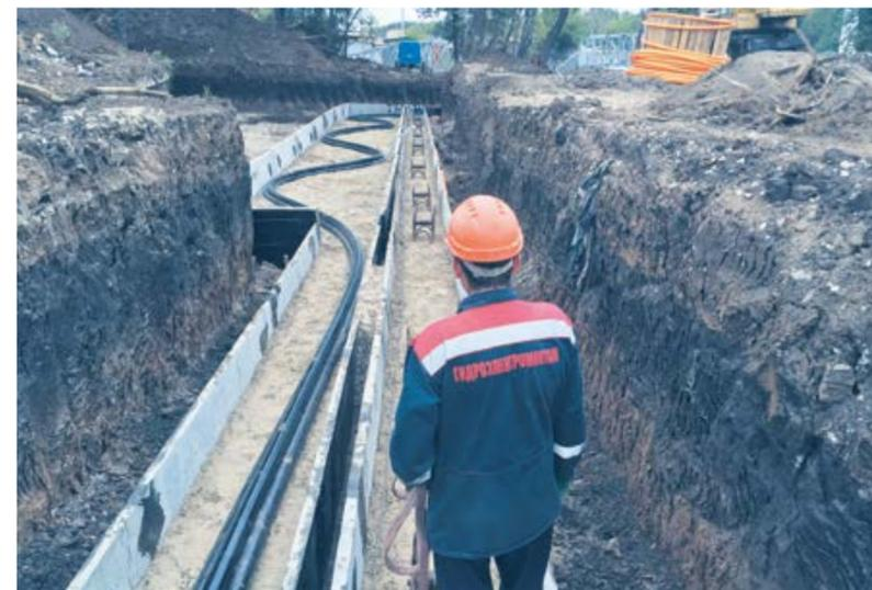
тромонтаж» проложен участок кабельной линии 110 кВ от переходного пункта № 3 до трансформаторной муфты № 1. Протяженность строительной длины двухцепного участка, на котором проложено 4605 метров кабеля, составляет 760 ме-
