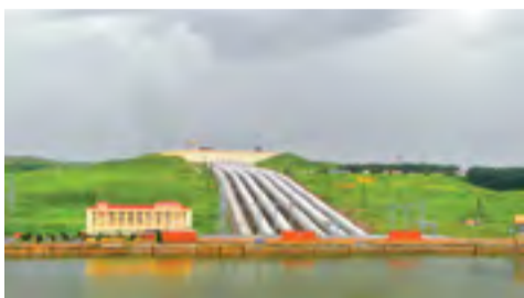
АО «ГЭМ» завершает работы на Загорской ГАЭС → стр. 3
