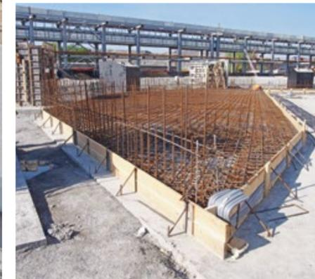
Сегодня усилия ПЭС сконцентрированы на градирне № 3. Так, уже установлены фундаменты каркаса башни, обеспечена 100%-ная готовность к началу монтажа самого металлокаркаса. В завершающей стадии находятся работы по устройству железобетонного водосборного бассейна. С соблюдением договорных и общих сроков стро-
