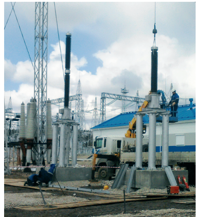
Работы на ПС «Амурская»
