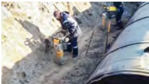
АО «ГЭМ» завершает строительство ПС 110 кВ «Маслозавод» → стр. 3
