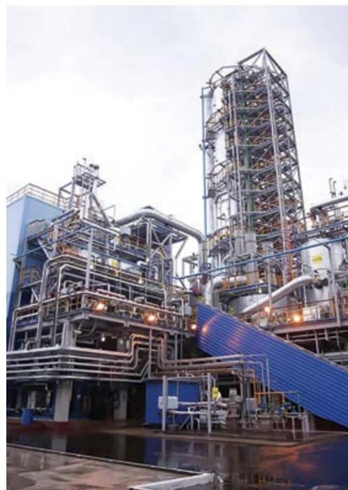
Специалисты ООО «Камазэлектромонтаж» продолжают выполнять работы на объекте «Производство изобутилена, мощностью 160 тысяч тонн в год» для ПАО «Нижнекамскнефтехим» (г. Нижнекамск, Республика Татарстан). В настоящее время кэмовцы ведут монтаж кабельных металлоконструкций, трубной разводки под сети
