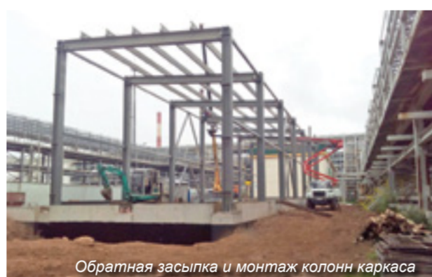
Обратная засыпка и монтаж колонн каркаса
