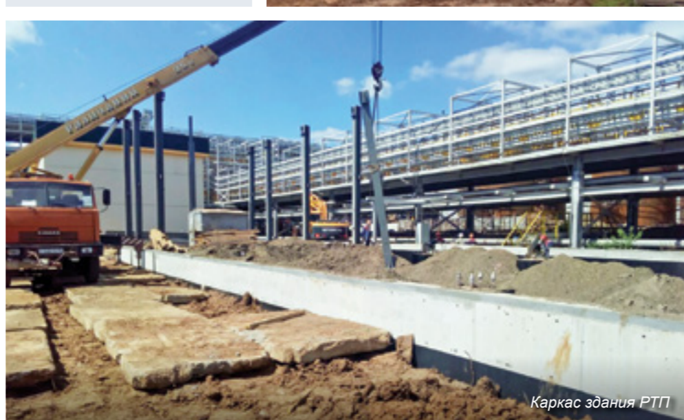
Обратная засыпка и монтаж колонн каркаса
