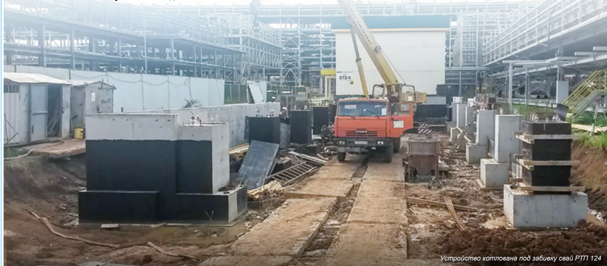
Устройство котлована под забивку свай РТП 124
