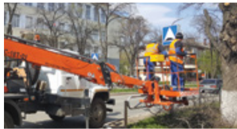
КЭМ ведет реконструкцию уличного освещения Чайковского
