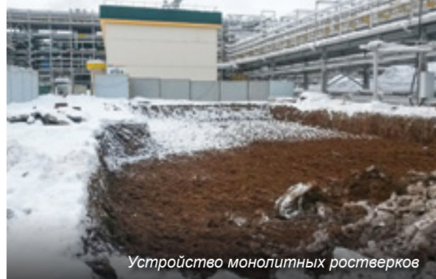
Устройство монолитных ростверков
