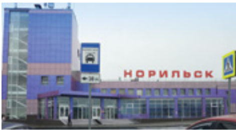
БалГЭМ строит энергообъекты в Норильске
