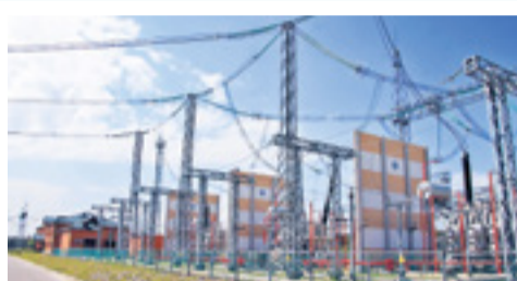
АО «ГЭМ» проведет реконструкцию ПС 750 кВ «Белозерская» → стр. 2
